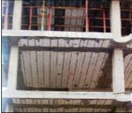
Strafor Asmolen ürünün döşenmiş hali (alttan çekilmiş görüntüsü)
