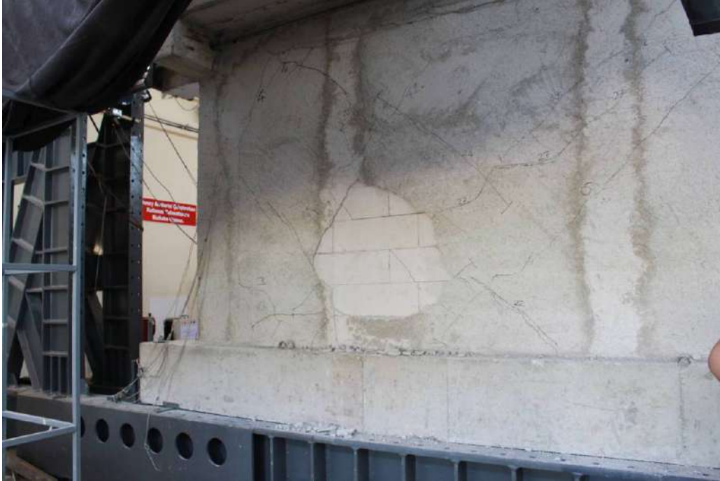
(d) Duvar arkasında gelişmiş ağ şeklindeki yaygın diyagonal çatlaklar, gazbeton birimleri arasındaki harç hasarları.
