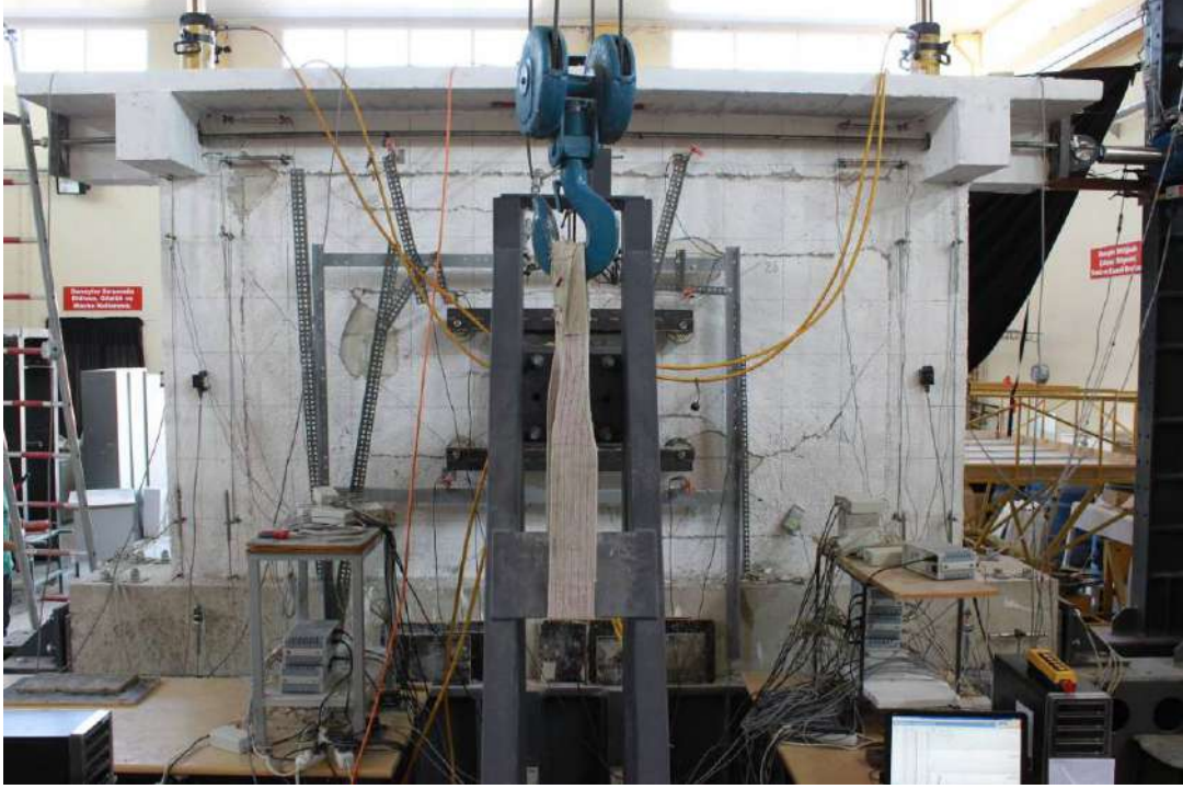
(e) Ön yüzde gelişmiş olan ilerlemiş çerçeve-duvar arayüzü hasarları ve diyagonal çatlaklar.
