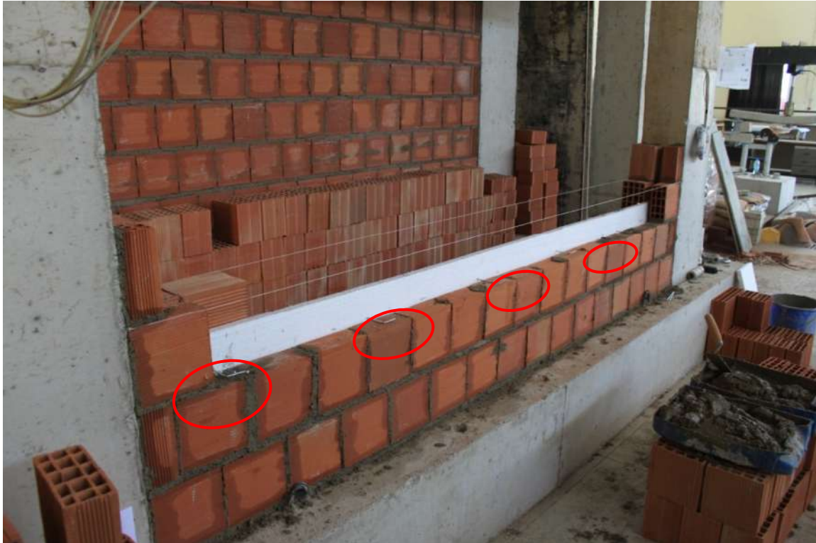
Şekil 4.8. Z bağlantılı “Sandviç Duvar”ın örülmesi.
