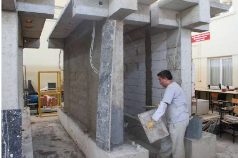
Şekil 4.11. Duvar örümü ve sıva işleri gerçekleştirilen N5 ve N6 numuneleri.
