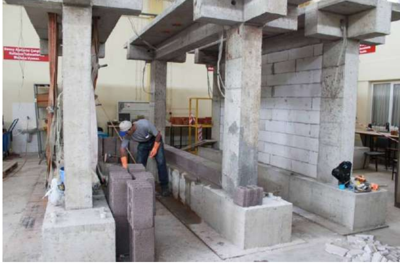
Şekil 4.10. Bims ve Gazbeton dolgu duvarların örülmesi.
