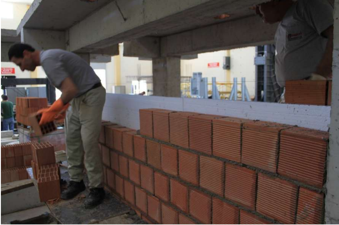
Şekil 4.7. Z bağlantısız “Sandviç Duvar”ın örülmesi.
