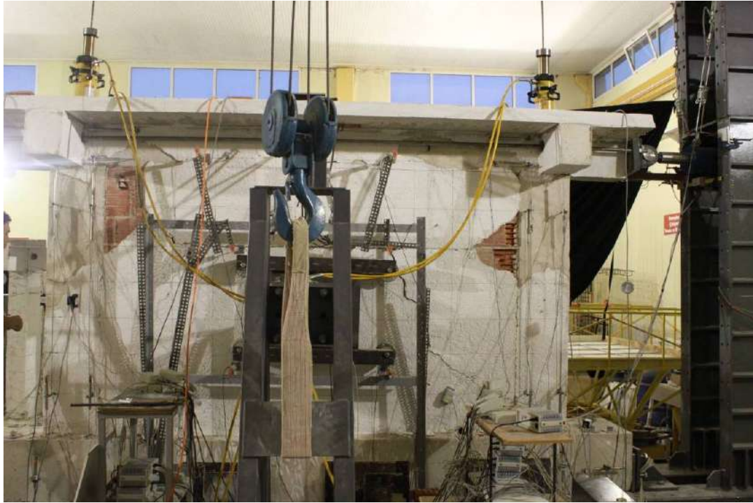
(c) Çerçeve ve duvar etkileşimi sonucu duvar köşelerinde oluşan ezilmeler, diyagonal duvar çatlakları ve birleşim bölgesi hasarları.
